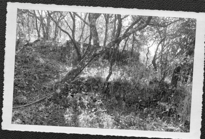
FIGURA 9 – Escombros da casa da cachoeira
