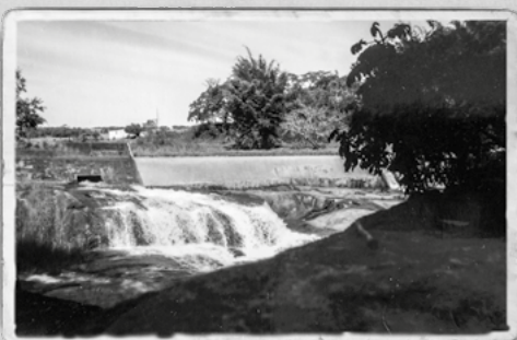
Na divisa de Conceição da Barra e Nazaré (mais especificamente na Fazenda do Bananal), funcionou entre 1930 e 1960 uma usina que fornecia iluminação elétrica às sedes desses distritos
