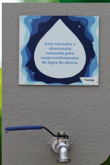
Torneira que utiliza água da chuva para limpeza.
