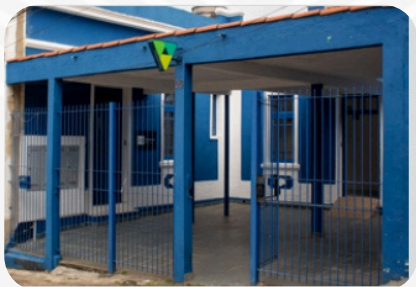
Posto de atendimento Santa Branca
