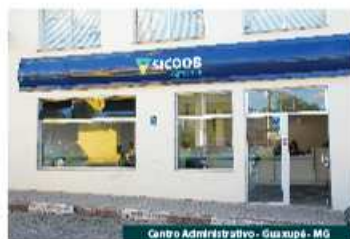
Centro Administrativo - Guaxupé - MG
