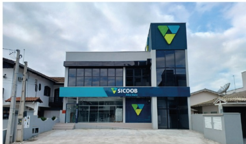
Fachada da nova agência em Pouso Redondo
