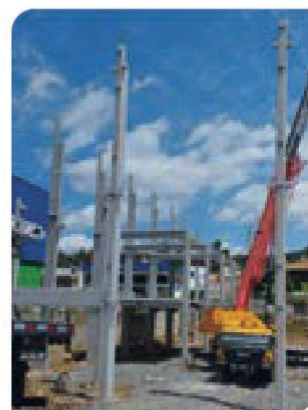
Sede Administrativa em construção.
