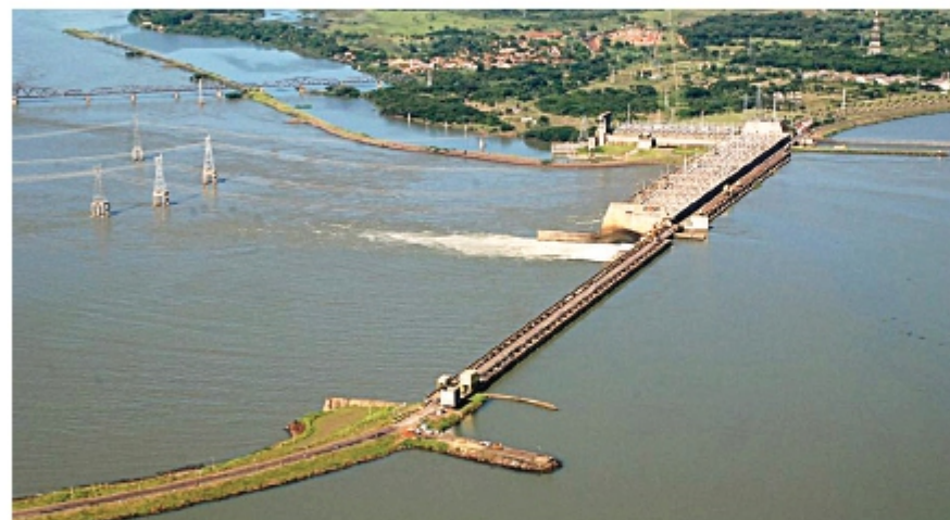
Barragem de Juplã, na divisa com São Paulo, dá acesso à cidade de três Lagoas (MS)
