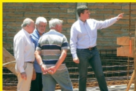
Jeferson Platzeck Estrella mostra o andamento da obra
