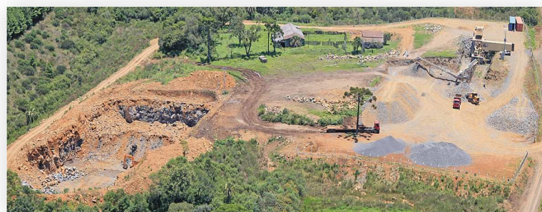
Puerari Terraplanagem - Santa Cecília/SC
